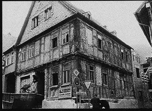
Sanierung Wohn- u. Geschäftshaus Gondermann, Strackgasse 4 in Bad Camberg
