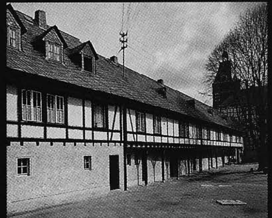
Wiederaufbau des Amtshofes und Ausbau zu Wohnungen Obertorstraße in Camberg
