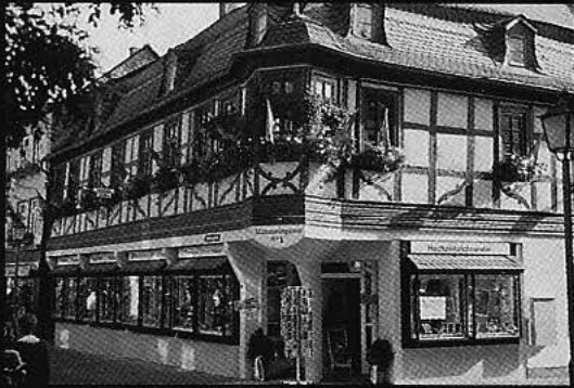
Sanierung u. Umbau eines Fotostudios im Altstadtbereich in Idstein M. Imhoff, Himmelsgasse 1
