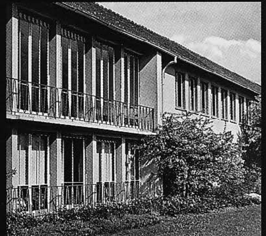
Erweiterung u. Umbau „Kurmittelhaus“ der Stadt im Kurpark in Camberg
