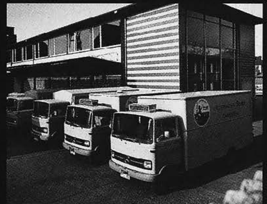
1982–1985 TROCKENMILCHWERK DER MILCHWERKE FULDA-LAUTERBACH IN LAUTERBACH 19 500 m 3 umbauter Raum Bauherr: Molkereigenossenschaft Fulda-Lauterbach
