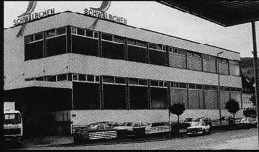
1989-1992 MILCHWERKE „SCHWÄLBCHEN-MILCH“ BAD SCHWALBACH Kühlhaus mit Fabrikation, 9500 m 3
