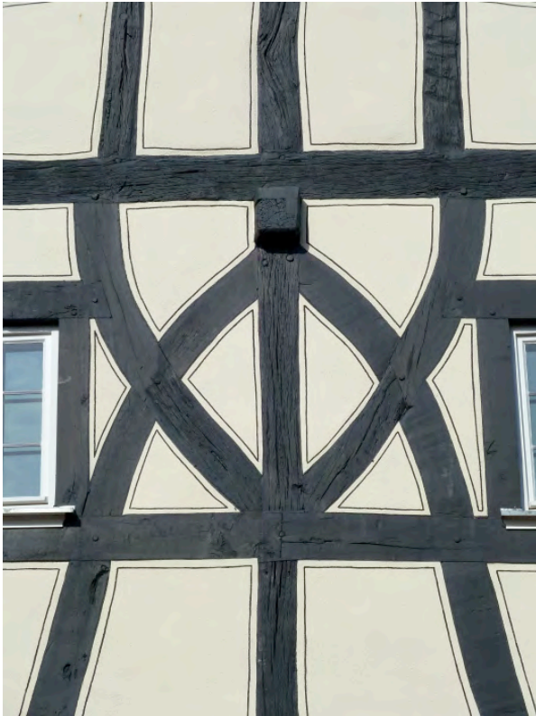
Abb. 6: Bundverstrebung im oberen Stockwerk
