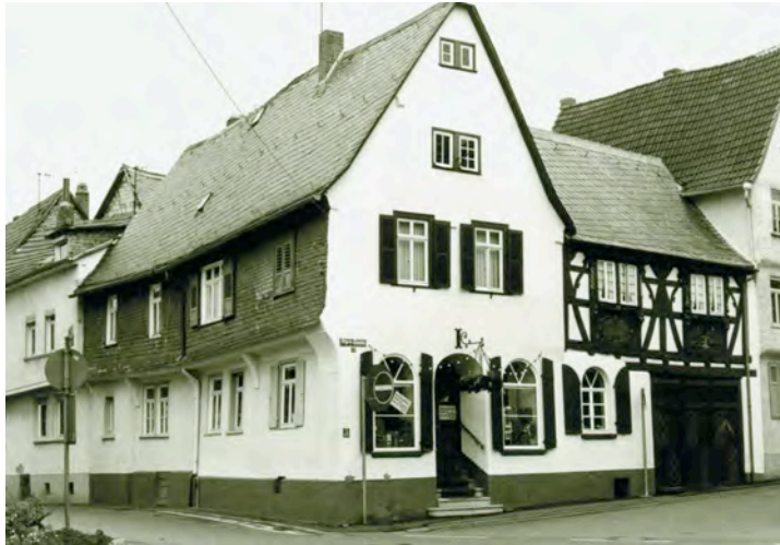
Abb. 9: Pfarrgasse 1 vor der Sanierung, um 1985
