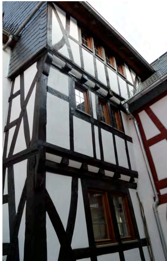
Abb. 12: Hofseite Pfarrgasse Nr. 3 zu Nr.1 zeigt ein Sichtfachwerk, wie es an Straßenseiten üblich ist.
